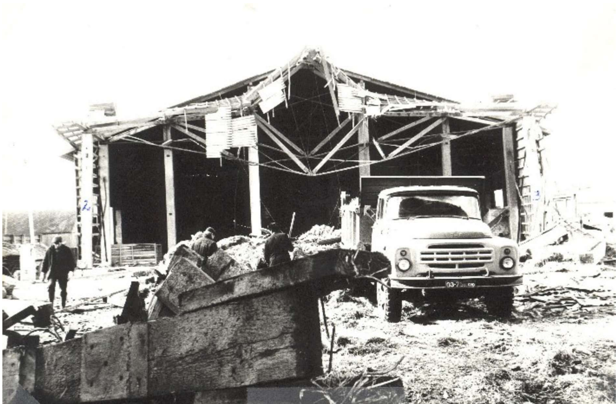
Joonis 1. Puitmetallsõrestiku varing
