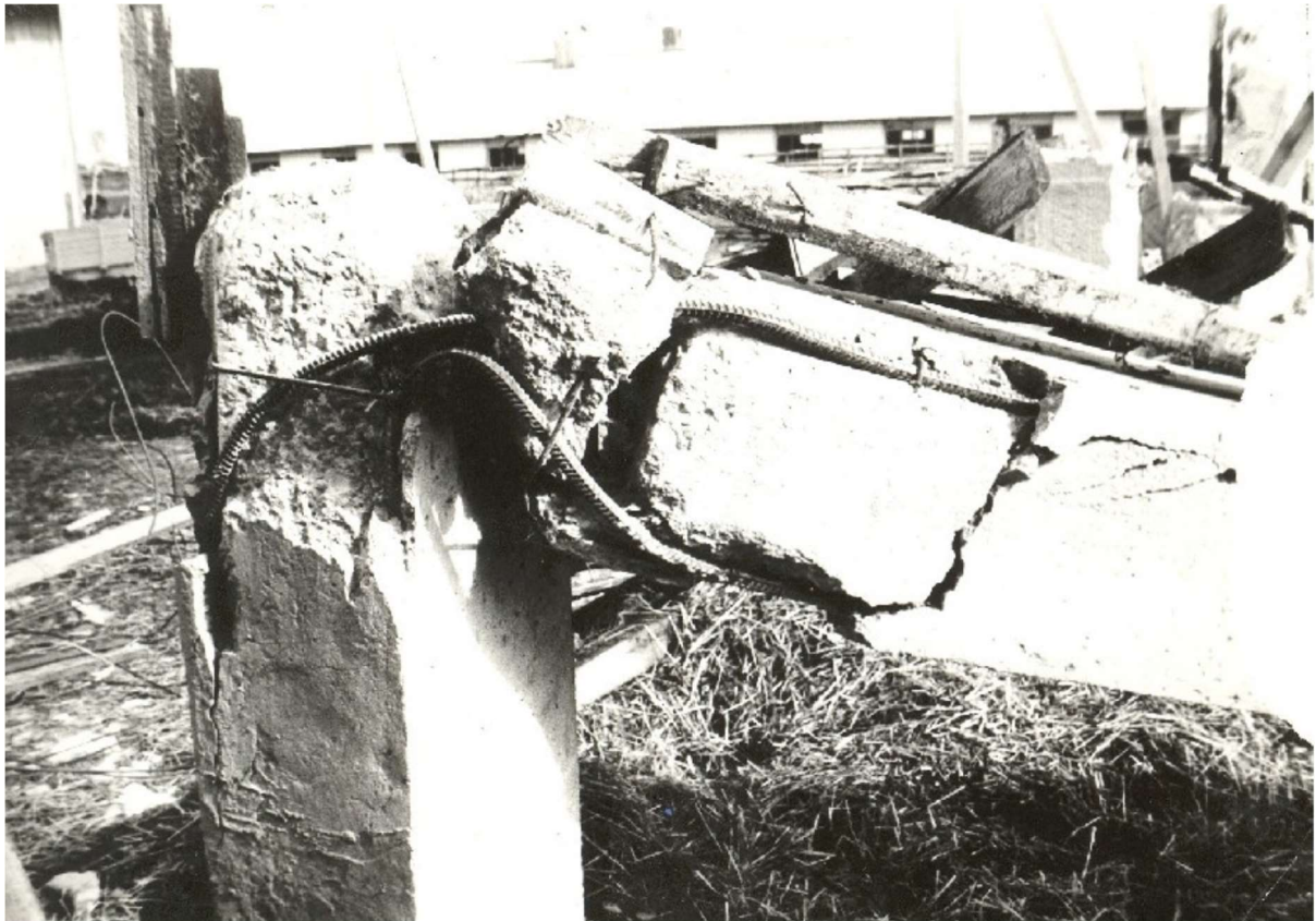
Joonis 3. Katusesõrestike varingul purunenud raudbetoonpost
