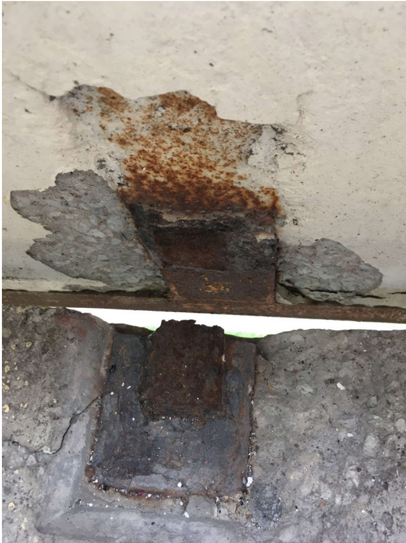
Joonis 3. Rõdupiirde alumise serva läbiroostetanud kinnitus
