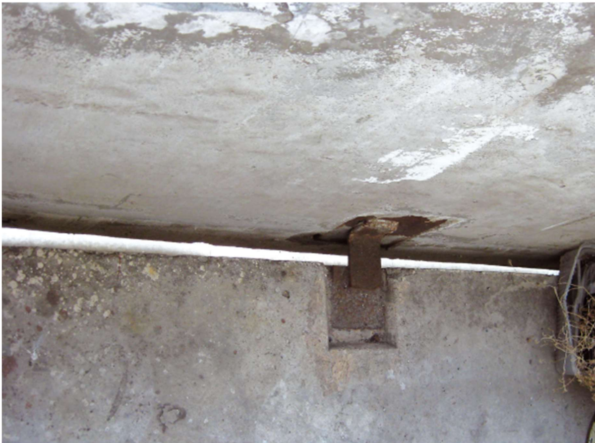
Joonis 2. Raudbetoonist rõdupiirde toetus rõduplaadi servale
