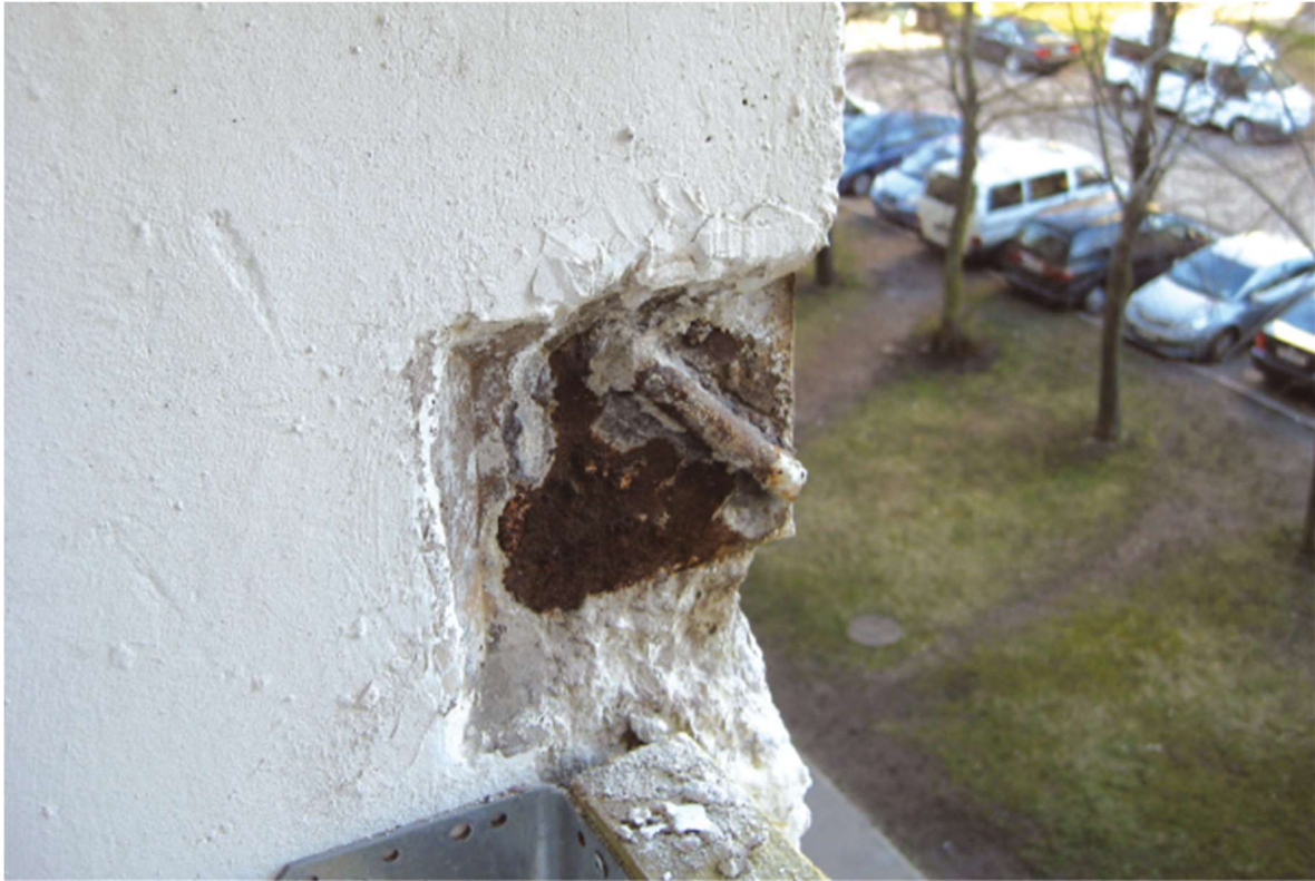
Joonis 1. Rõdupiirde mitteprojektikohane keevterasest kinnitus
