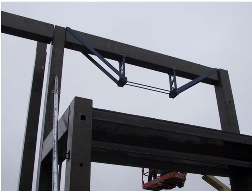
Joonis 1. Terasest sprenglersõrestikuga tugevdatud tala
