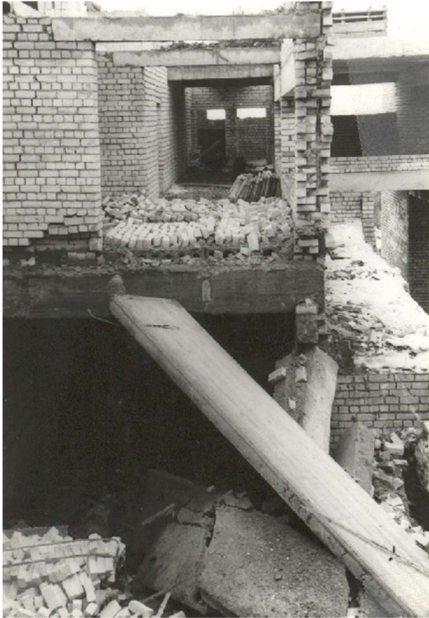
Joonis 1. Mitmekorruselise hoone varing ehitustööde käigus
